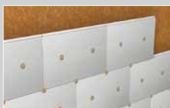
Mocowanie płyt styropianowych do paneli drewnopochodnych
