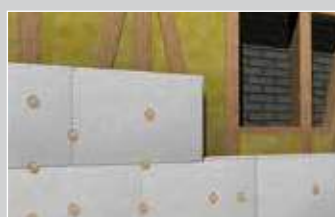
Mocowanie miękkich płyt styropianowych do drewna
