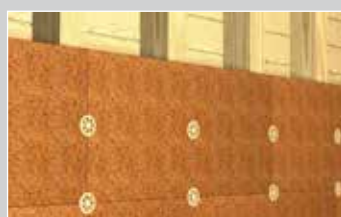
Mocowanie płyt z miękkiej wełny mineralnej do drewna
