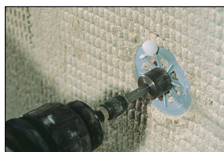
Montáž upevnění skrz zpevňovací skleněnou síťovinu
