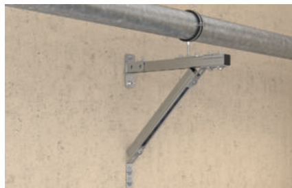
Instalacja rurociągu na wsporniku
