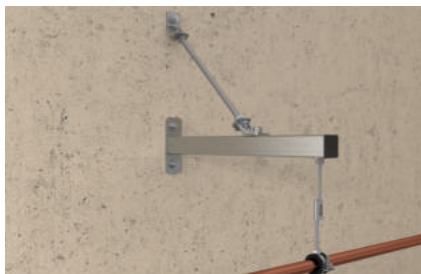
Podwieszenie rurociągu do wspornika
