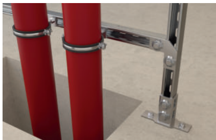
Mocowanie rur spustowych do konstrukcji wsporczej
