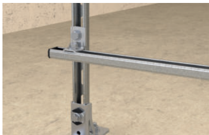
Mocowanie konstrukcji wsporczej do posadzki
