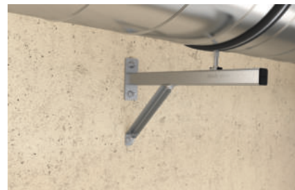
Rura wentylacyjna zamontowana do ściany
