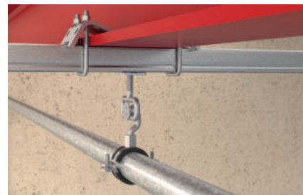
Podwieszenie rurociągu na wieszaku przesuwnym
