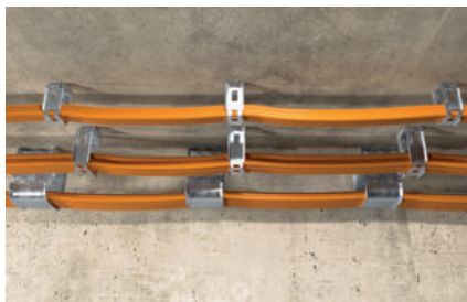
Mocowanie kabli do stropu
