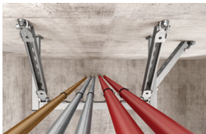
Stężenie konstrukcji ramowej, wykonanej z szyn montażowych
