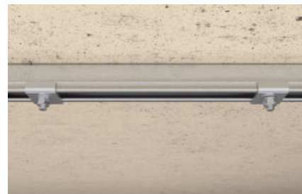
Szyna montażowa zamocowana do ściany
