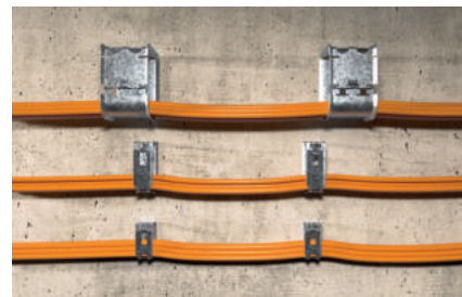
Mocowanie kabli do ściany
