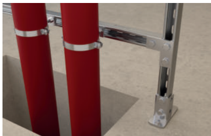
Rury spustowe zamontowane na obejmach
